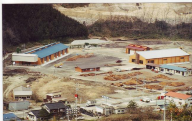
製材所建設当時の木材団地
