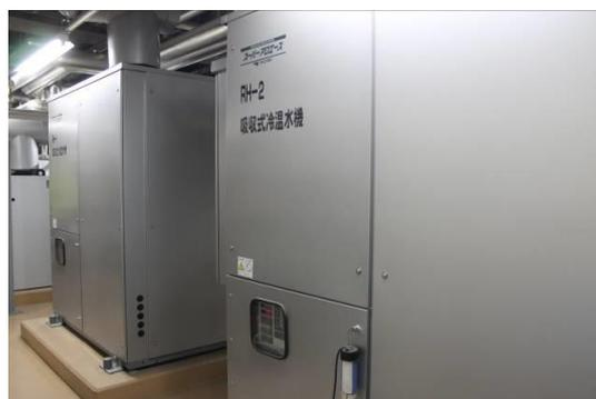
図表 4-8 吸収式冷凍機
