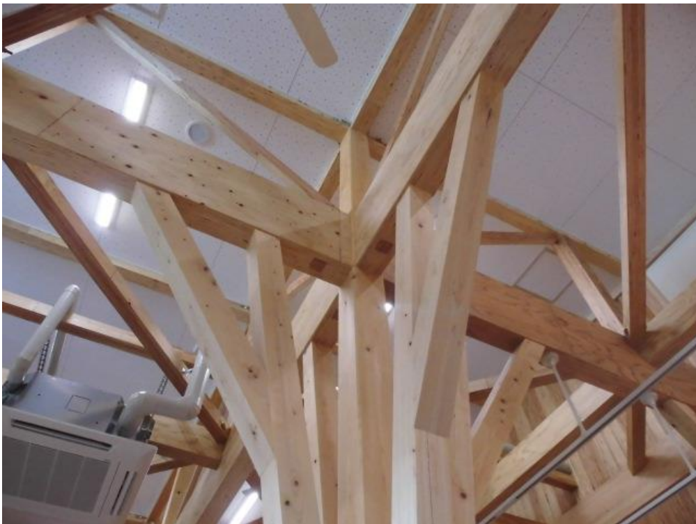
町産材を使用した道の駅にちなみ日野川の郷の構造材
